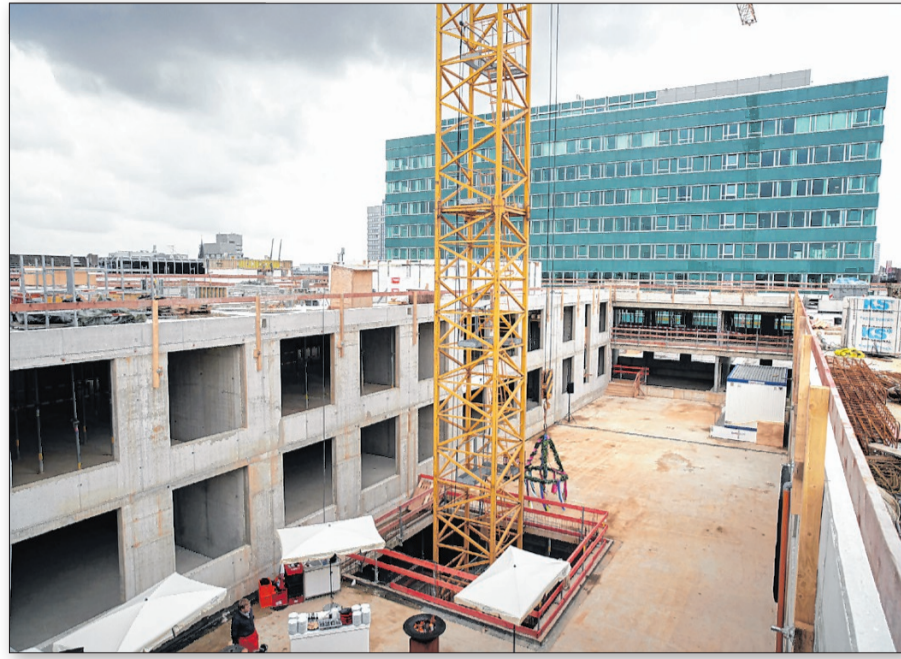
Der riesige Kran wurde von einem großen Kran vor einer Woche in die Luft gezogen. Diese Tradition durfte beim Richtfest nicht fehlen. Foto: ila
