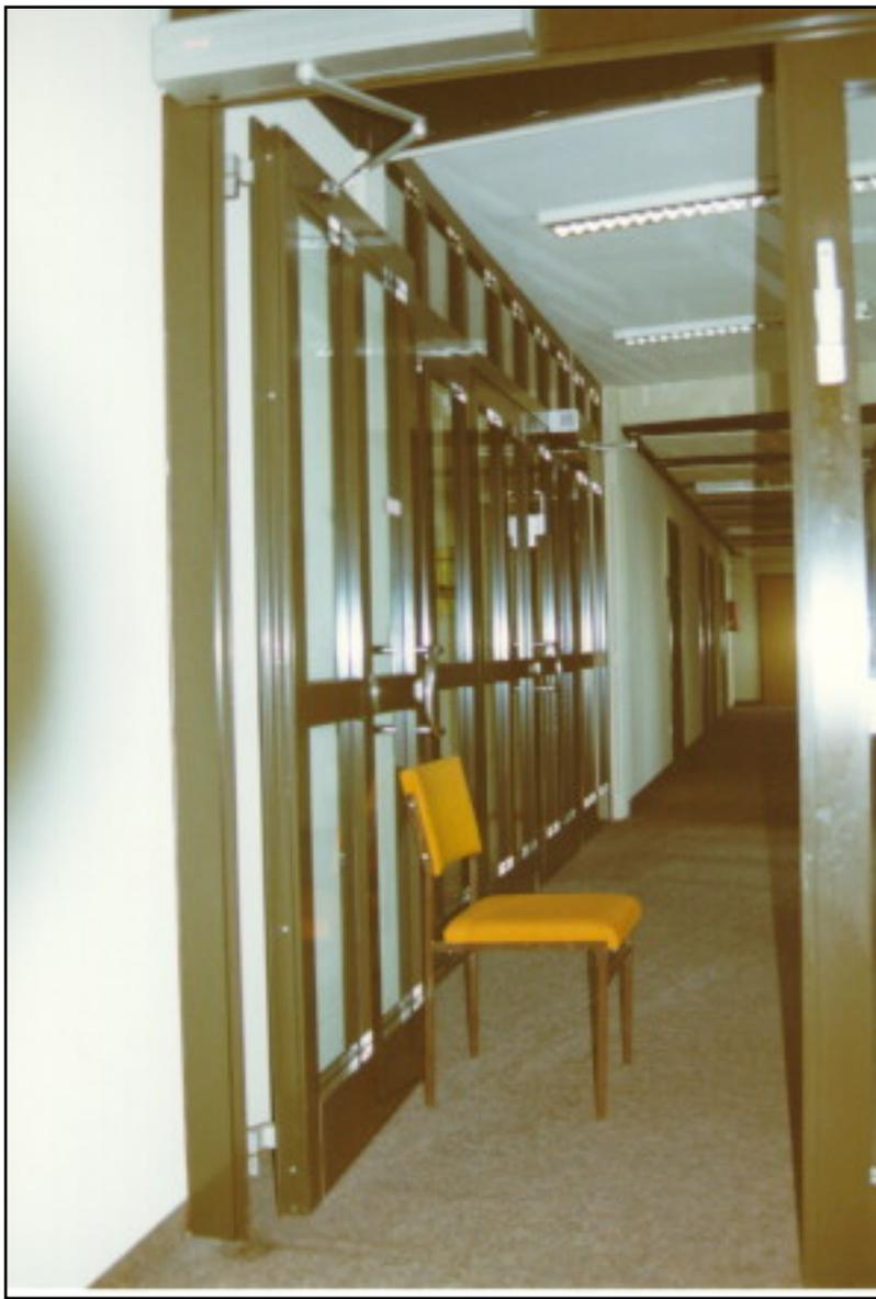
Besonders "vorteilhaft" für die Ausbreitung von Brandrauch ist hier die durch einen Stuhl aufgekeilte Rauchschutztür!
