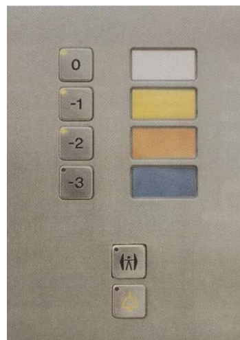
Abbildung 5-4: Farbschema in einem Aufzug einer Tiefgarage 50
