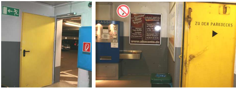
Abbildung 4-2: Zugangstüren zu den Parkdecks in der Friedensplatzgarage in Bonn
