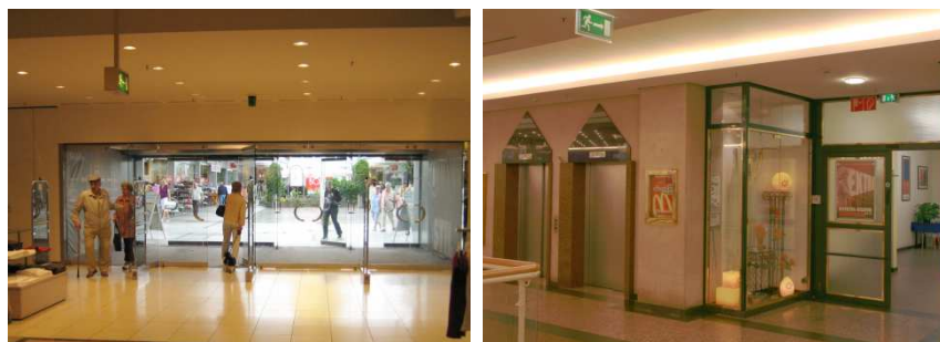
Abbildung 4-5: Fehlende Ausgangsbeschilderung in den Geschäften (Ruhr-Park, links) und an den Aufzügen zu den Stellplätzen (RRZ, rechts)
